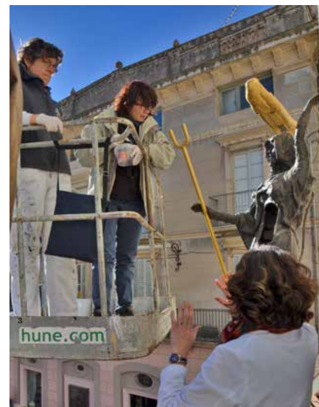
1. Restauration de la lampe du Casino Sport, à l'entrée de la Salle Mae West Restoration of the Casino Sport lamp, at the entrance to the Mae West Room 2. Intervention sur la tête de « Sainte Thérèse » de Bernini Intervention on the head of "Saint Teresa" by Bernini Dalinized 3. Traitements périodiques des œuvres situées en plein air Periodic treatments of works displayed in the open air
