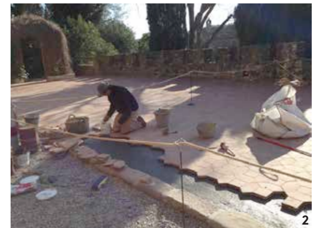
1. Cleaning the eggs that crown Torre Galatea 2. Building work on the Tithe Terrace, in Púbol 1. Nettoyage des œufs qui couronnent la Tour Galatea 2. Travaux de maçonnerie sur la terrasse de la Dîme, à Púbol
