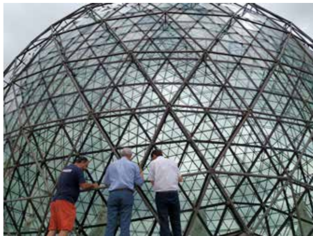
Repintat de la façana de Torre Galatea / Repintado de la fachada de Torre Galatea Habilitació d'un pati a la sortida del TMD / Habilitación de un patio a la salida del TMD Avaluació tècnica de l'estat de la cúpula / Evaluación técnica del estado de la cúpula
