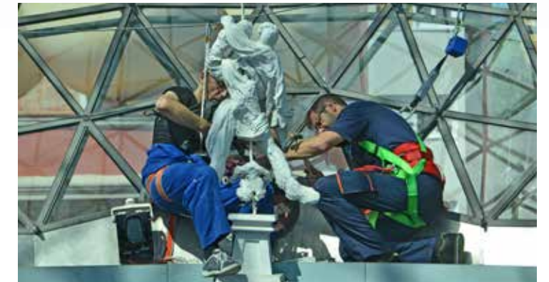
Revisión del sistema de sujeción de las esculturas
