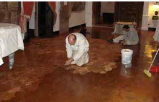
Decapado y pintado del pavimento de la Sala del Piano
