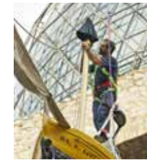
Reparación del paraguas
