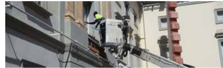
Fijación de elementos en la fachada este del Teatro-Museo
