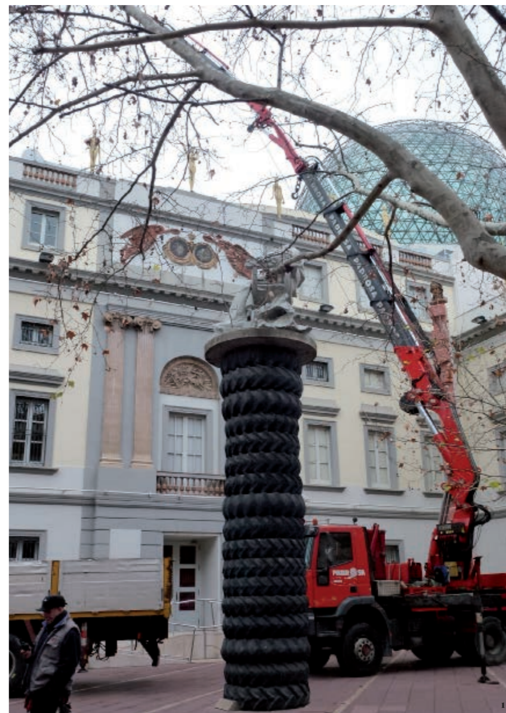
1. Amélioration de la climatisation du Théâtre-musée Dalí 2. La consigne de la sortie, rénovée 3. Installation d'un écran d'information à la consigne de la sortie
