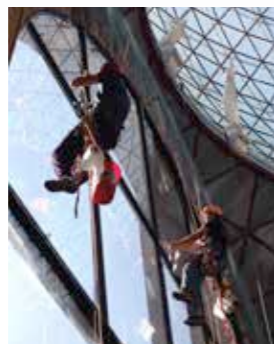
Nettoyage annuel de la verrière centrale
