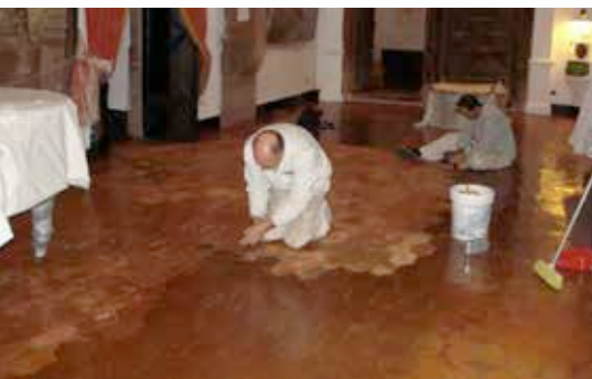
Décapage et peinture du sol de la Salle du piano
