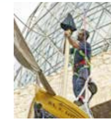
Réparation du parapluie
