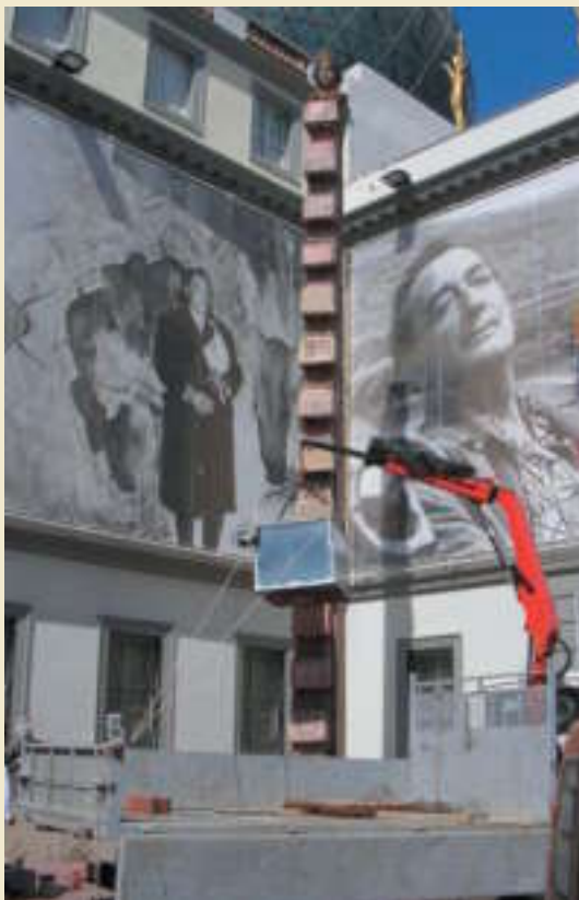
Work on the Vostell television sets column, outside the Theatre-Museum Intervention sur la colonne de télévisions de Vostell, à l'extérieur du Théâtre-musée
