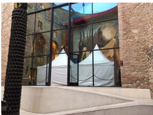
Instalación de carpas bajo la cúpula del Teatro-Museo Dalí
