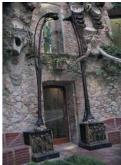
Restauración de los faroles modernistas Restauració dels fanals modernistes
